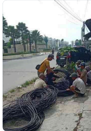
Penggelaran kabel di Tembung
