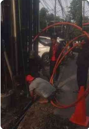
Penarikan duct di Sei Sikambing, Medan
