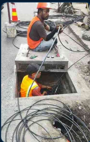
Penarikan kabel di manhole, Medan Petisah
