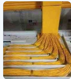
Penataan kabel optik
