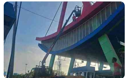
Pekerjaan di ketinggian di Belawan
