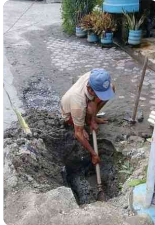
Galian di Percut Sei Tuan
