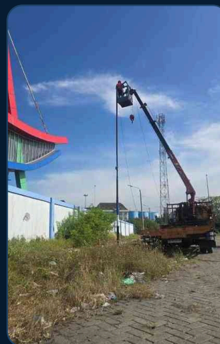
Pemasangan tiang dengan boom lift di Belawan
